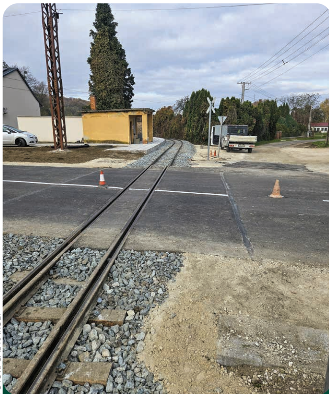
A felújított pákai vasúti átgáró és utasperon
