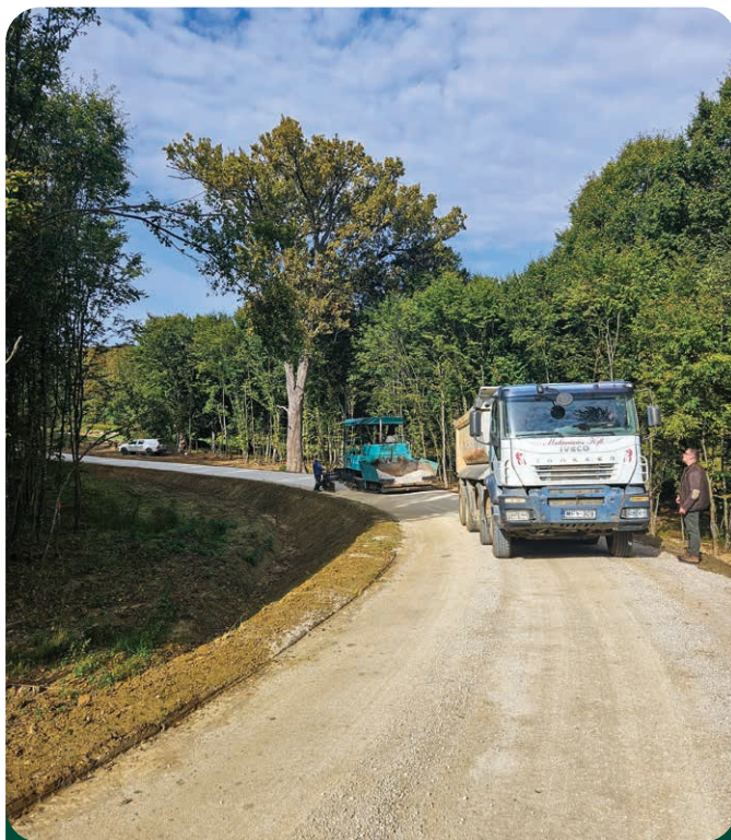
Utolsó munkaműveletek egyike, útpálya profilhelyes kialakítása finisher berendezéssel
