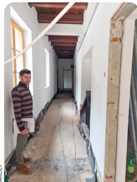
Lesták Attila építési előadó ellenőrzi a kivitelezés folyamatát
